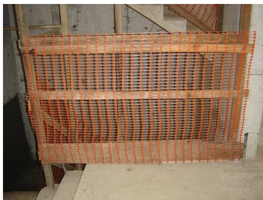
Figura 46: Utilização de rodapé de tábua agreste nos patamares da escada. Fonte: SESI – BA
