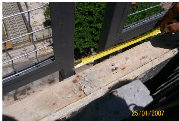
Figura 31: Medida de 10 cm entre os guarda-corpos. Fonte: SESI – BA
