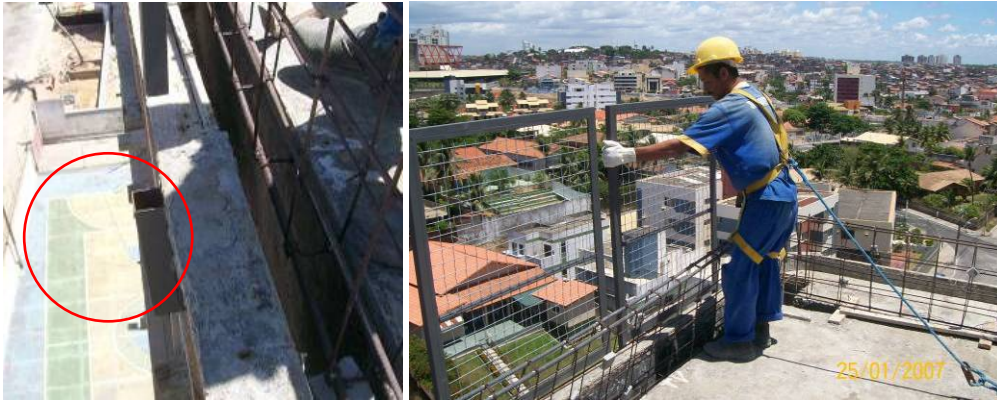
Figura 30: Posição da peça de suporte (à esquerda) e a colocação do guarda-corpo (à direita). Fonte: SESI – BA
