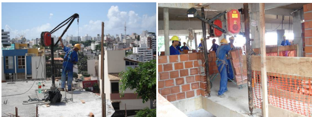
Figura 17: Minigrua na última laje (à esquerda) e no poço do elevador (à direita). Fonte: SESI – BA
