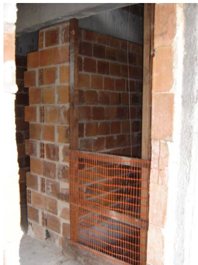
Figura 36: Primeira solução para guarda-corpo de vão de elevador. Fonte: SESI – BA
