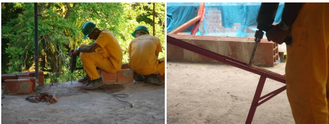
Figura 2: Operários fazendo os furos necessários para a fixação da bandeja. Fonte: SESI – BA
