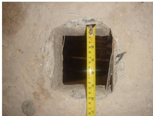
Figura 21: Mensuração da abertura na laje. Fonte: SESI – BA
