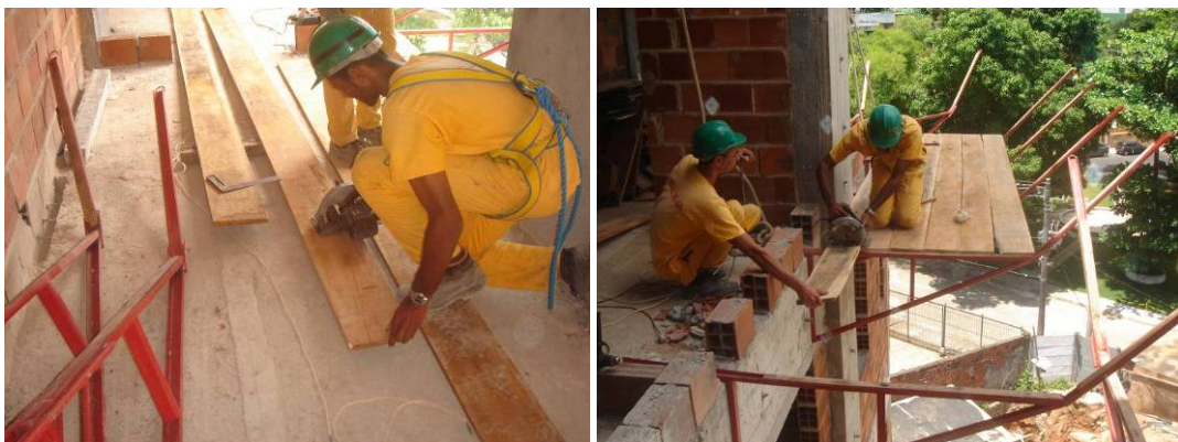
Figura 4: Corte da tábua dentro do pavimento (à esquerda) e com a tábua sobre os perfis metálicos (à direita). Fonte: SESI – BA
