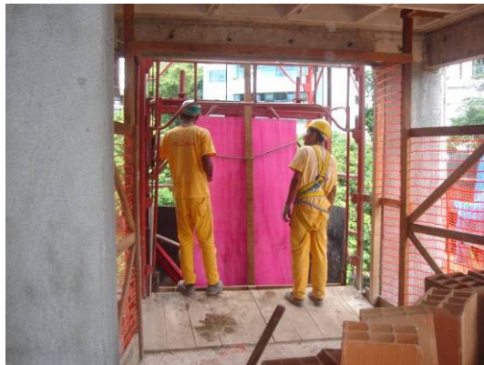
Figura 9: Colocação dos materiais no elevador de carga. Fonte: SESI – BA
