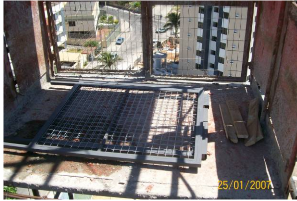
Figura 27: Dois guarda-corpos sendo transportados no elevador de carga. Fonte: SESI – BA
