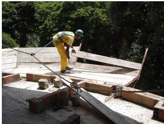
Figura 6: Processo de desmontagem da bandeja convencional. Fonte: SESI – BA
