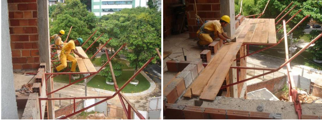
Figura 3: Colocação das tábuas nos perfis. Fonte: SESI – BA
