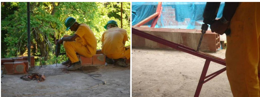
Figura 2: Operários fazendo os furos necessários para a fixação da bandeja. Fonte: SESI – BA
