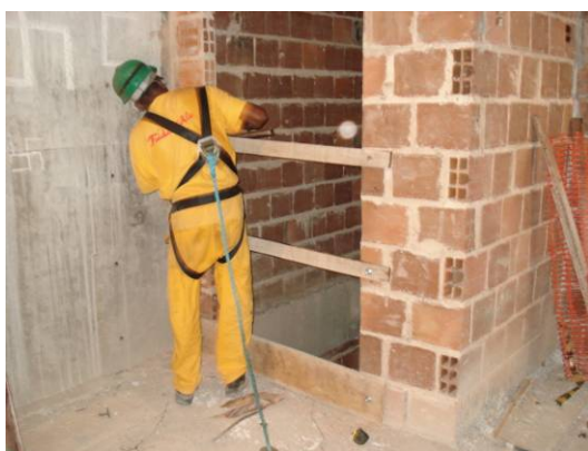
Figura 41: Montagem do guarda-corpo de poço de elevador. Fonte: SESI – BA
