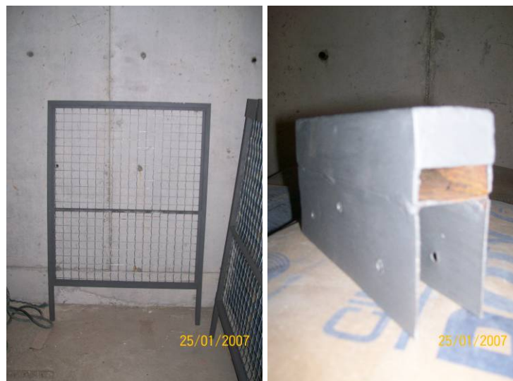
Figura 26: Guarda-corpo (à esquerda) e peça de suporte (à direita). Fonte: SESI – BA
