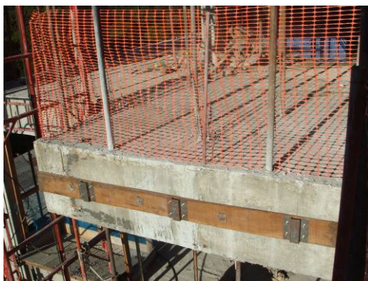
Figura 33: Madeira preparada para a colocação do guarda-corpo. Fonte: SESI – BA
