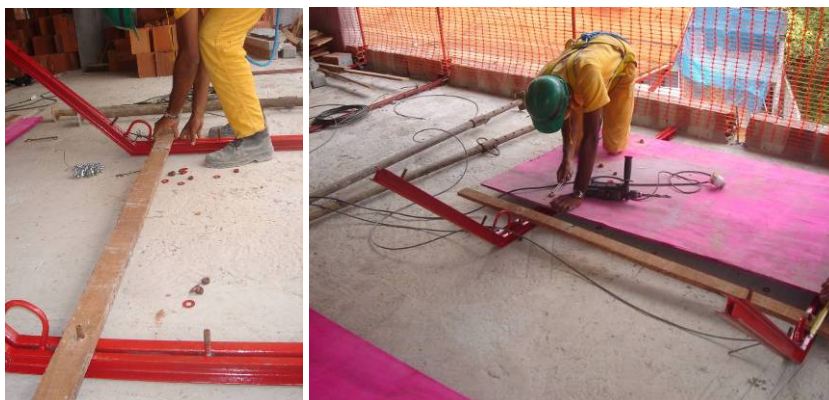
Figura 11: Fixação da ripa e da chapa compensada no perfil metálico. Fonte: SESI – BA
