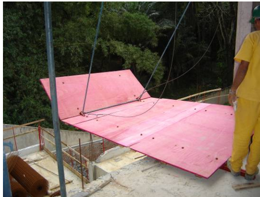
Figura 14: Instalação da nova bandeja primária com uso de corda. Fonte: SESI – BA
