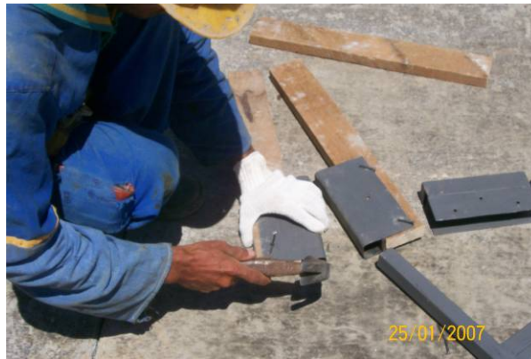
Figura 28: Operário fixando uma peça de suporte em um pedaço de madeira. Fonte: SESI – BA
