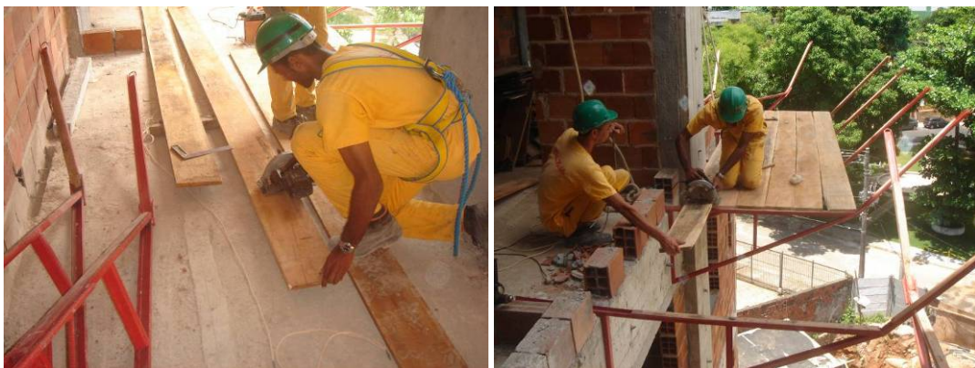
Figura 4: Corte da tábua dentro do pavimento (à esquerda) e com a tábua sobre os perfis metálicos (à direita). Fonte: SESI – BA
