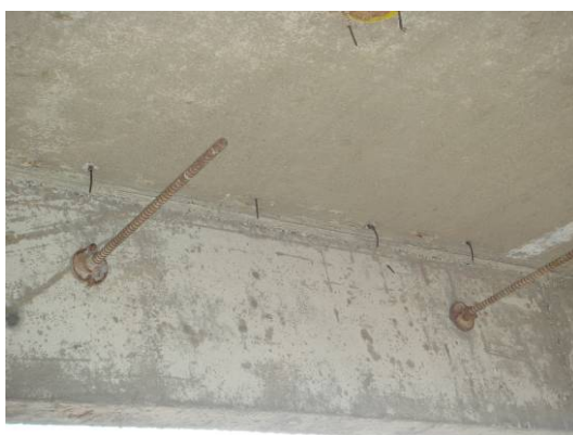
Figura 34: Parafusos de viga fixando a madeira (vista por dentro do pavimento). Fonte: SESI – BA
