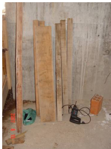
Figura 38: Materiais para a montagem da segunda solução para a abertura de elevador. Fonte: SESI – BA
