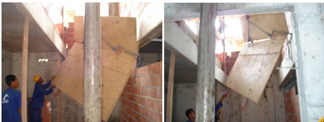
Figura 18: Transporte da bandeja com uma minigrua. Fonte: SESI – BA
