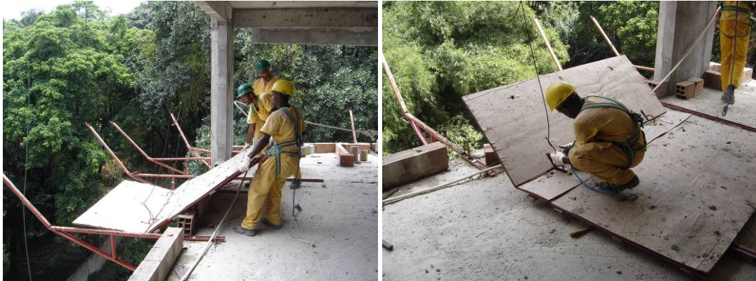
Figura 16: Retirada da nova bandeja (à esquerda) e do cabo de aço (à direita). Fonte: SESI – BA
