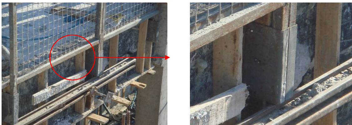
Figura 29: Peça metálica de fixação do guarda-corpo. Fonte: SESI – BA
