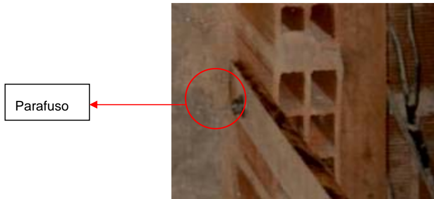
Figura 42: Fixação do guarda-corpo de abertura de elevador. Fonte: SESI – BA
