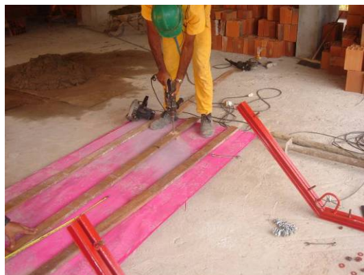
Figura 10: Execução dos furos nas ripas. Fonte: SESI – BA
