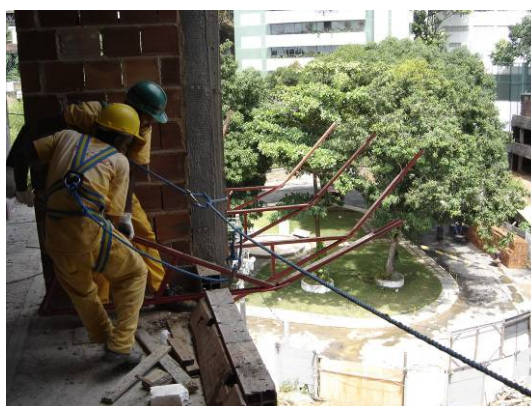
Figura 7: Processo de retirada do perfil metálico. Fonte: SESI – BA
