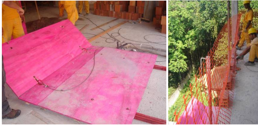
Figura 13: Bandeja com os cabos de aço (à esquerda) e operários segurando os cabos de aço da bandeja (à direita). Fonte: SESI – BA
