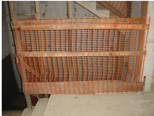
Figura 46: Utilização de rodapé de tábua agreste nos patamares da escada. Fonte: SESI – BA
